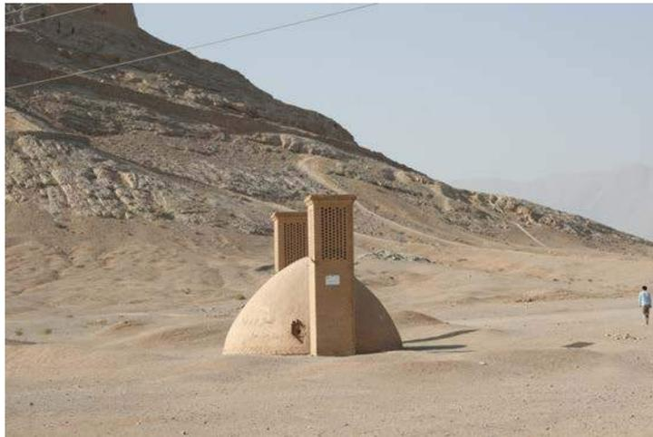
写真 1. 地下のカナートを利用した飲料水タンク（写真：Vafadarimehrizi Kazem）
